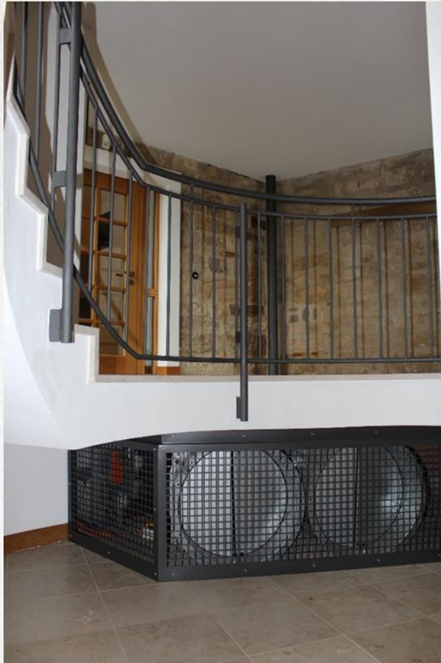
Rauchschutz-Druck-Anlage
