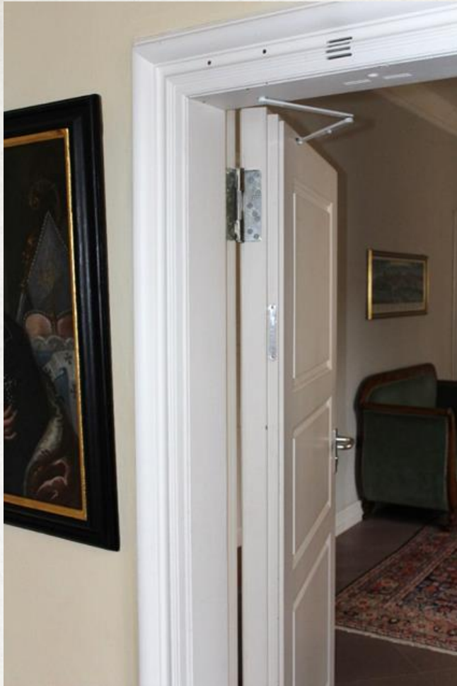
T-90_Feuerschutztür aus Holzwerkstoffen
