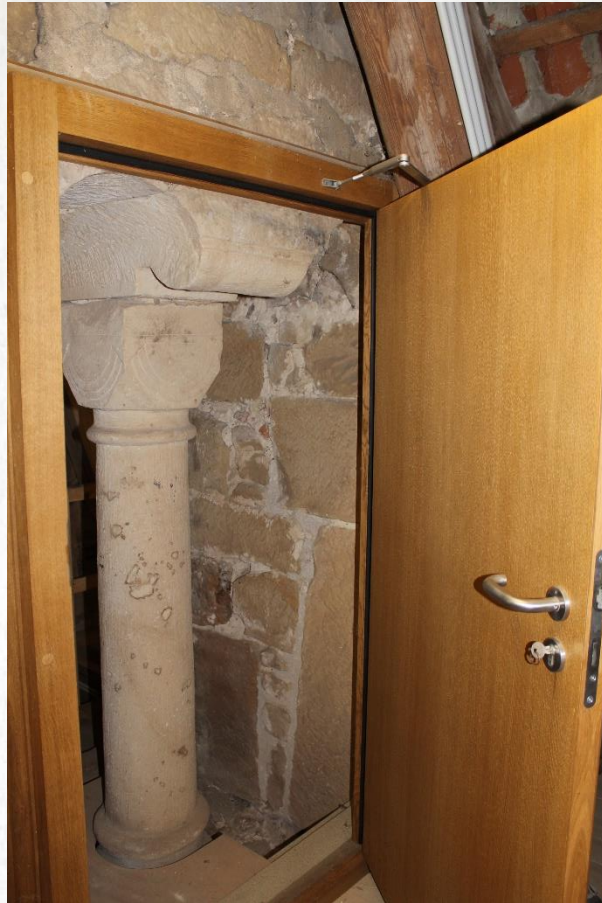
Neue T 30- Feuerschutzschutztür
