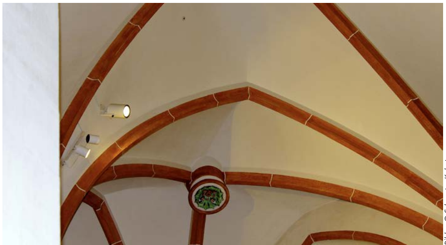
(8) Blick zum Gewölbe mit der kleinen Bohrung vom Rauchansaugsystem als Brandmeldeanlage
